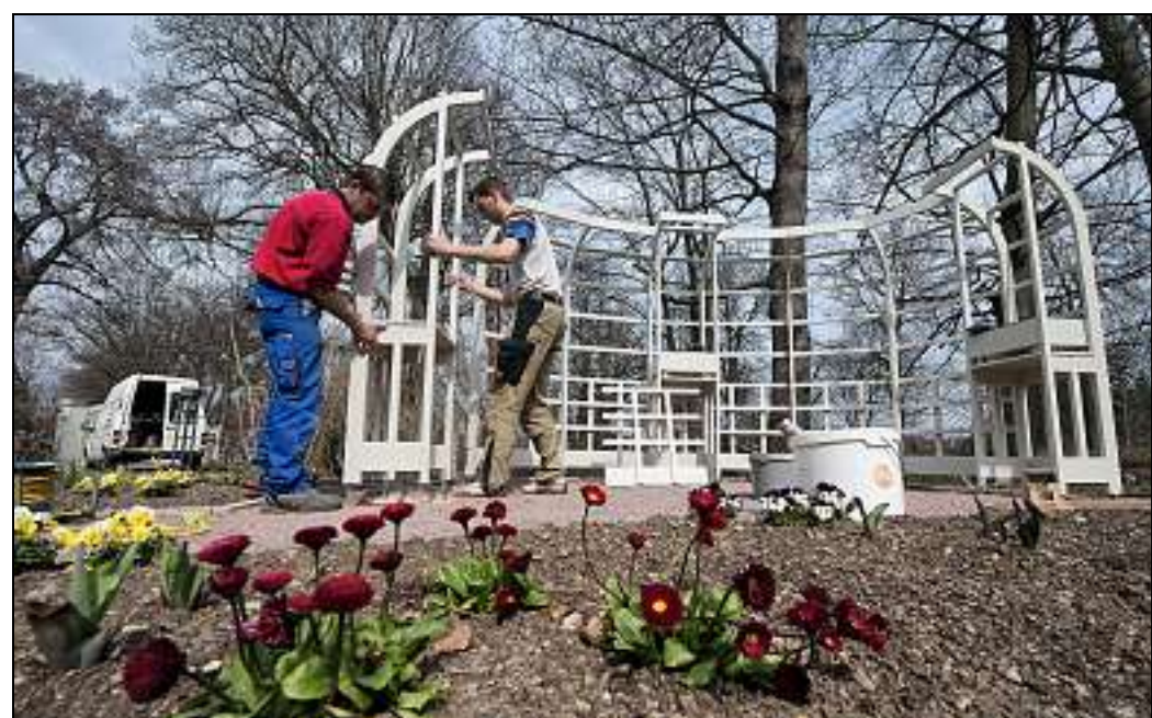
Gartenlust. 1907/08 ließ Henry van de Velde das „Haus Hohe Pappeln“ als privates Wohnhaus nach eigenen Plänen errichten. Neben der Architektur, den Einbauten und den Möbeln entwarf er auch den Garten. Die nach historischen Fotografien rekonstruierte Laube wurde gestern durch die Schreinerei Wolfgang Kalkoff in Niederroßla wieder aufgebaut. Im Bild: Christian Kalkoff und Mario Vetter. Foto: Maik Schuck
